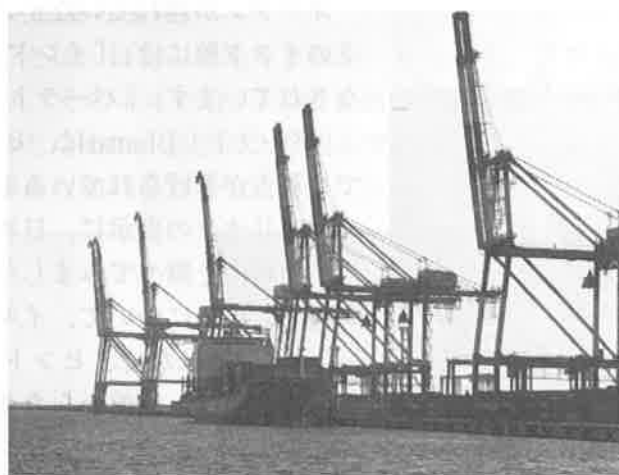
(夢洲のガントリークレーン)
